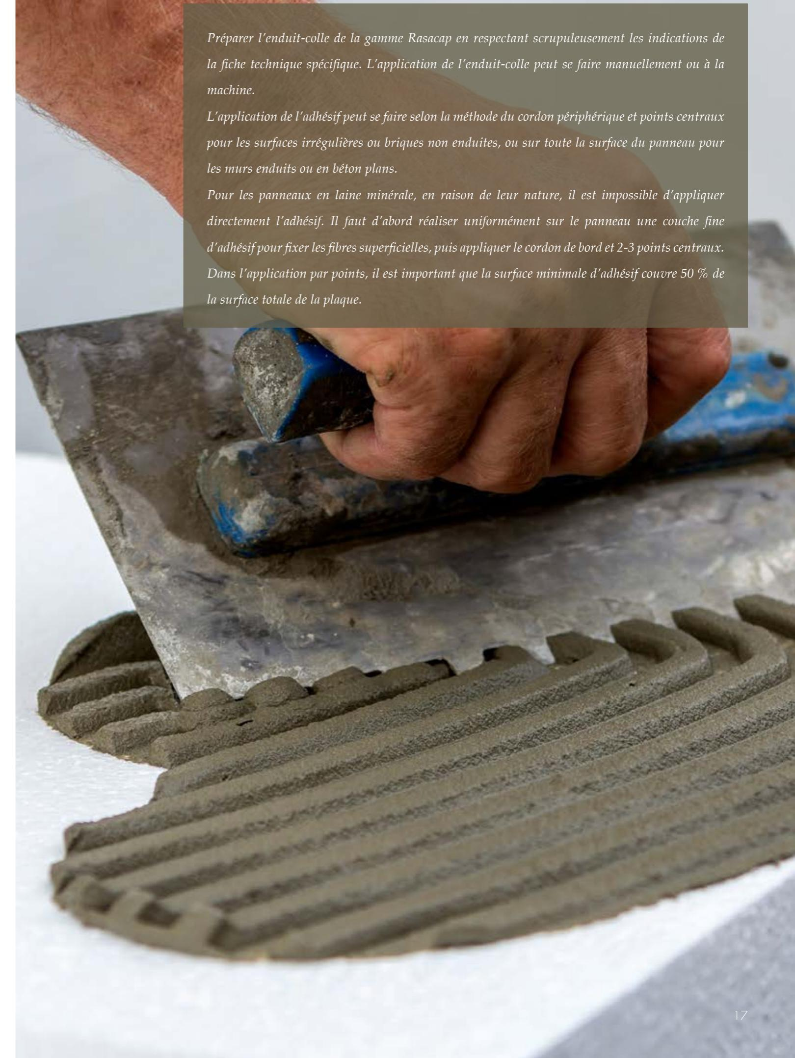
Préparer l'enduit-colle de la gamme Rasacap en respectant scrupuleusement les indications de la fiche technique spécifique. L'application de l'enduit-colle peut se faire manuellement ou à la machine.
