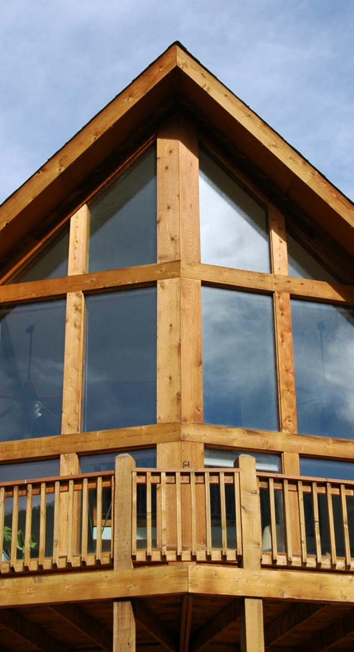
Construction correcte, dans laquelle la tête du montant est protégée, réduisant ainsi les risques d'absorption d'humidité.
