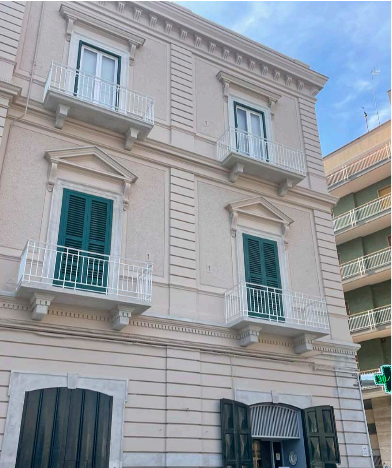
Wohngebäude, Bisceglie (BT) Anstrichsystem: Untergrundvorbereitung: PRIMER TOP - Endbeschichtung: SIL MATT ACTIVE
